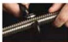
Utnij potrzebny odcinek rury
