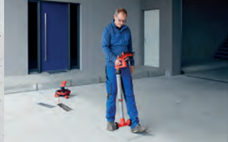
Za pomocą modułu ROLOC Plus HD można szybko odnaleźć nadajnik lokalizujący.
