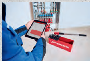
Tworzenie protokołu kontrolnego za pomocą aplikacji
